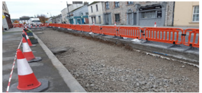
N77 - Béal Átha Rágrad - Oibreacha ar siúl ar atógáil na pábhála lochtaí
